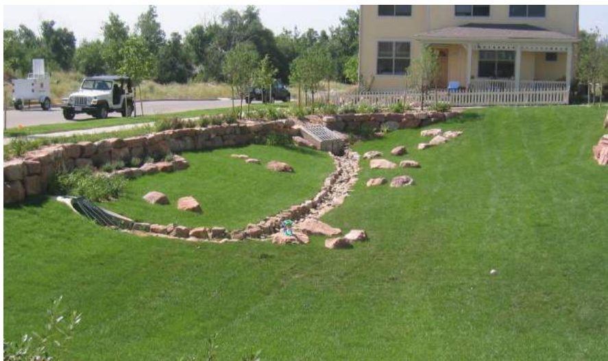
Figura 35 - Residencias de la Alianza de Viviendas Asequibles del Desarrollo Norte de Boulder Holiday Cuenca de Detención / Calidad del Agua
